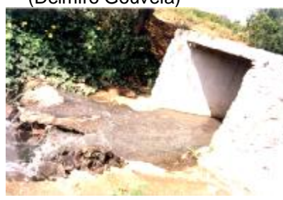
(d) Galeria de águas pluviais que recebe esgoto de ligações clandestinas (Canindé do São Francisco)
