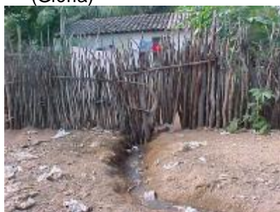
(c) Escoamento de esgoto (Pariconha)
