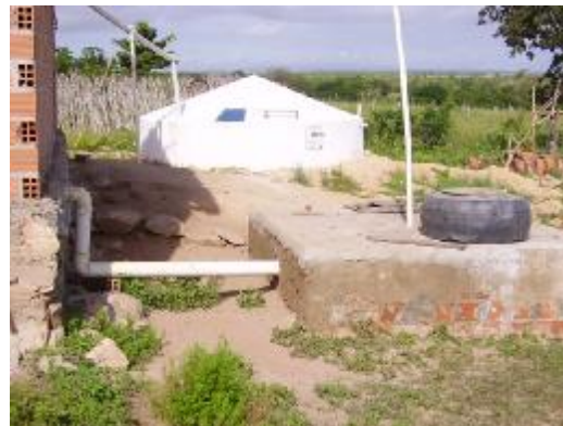
(d) Fossa com distância inferior a 30 m da cisterna
