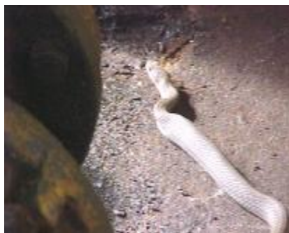
(e) Ofídio peçonhento em estação elevatória (Macururé-BA)
