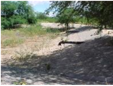
(a) Lagoa de estabilização abandonada (Itacuruba)
