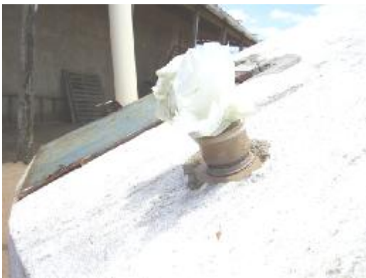
(e) Bomba de bola de gude retirada da cisterna
