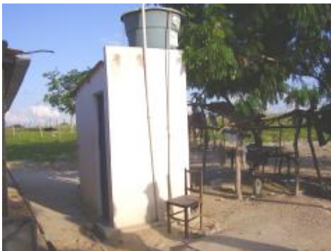
Figura 7.17: Reservatório, localizado acima do banheiro, para descarga do vaso sanitário.
