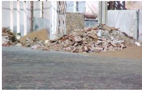
(c) Entulhos em local impróprio (Belém do São Francisco)
