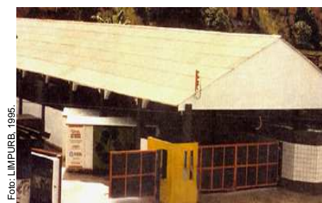
Figura 13 – Vista parcial do galpão de armazenamento do lixo coletado no Programa Recicla Salvador
