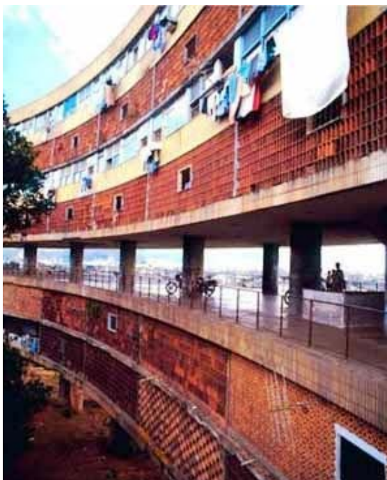
FIGURA 14 – Foto - Conjunto residencial Pedregulho
