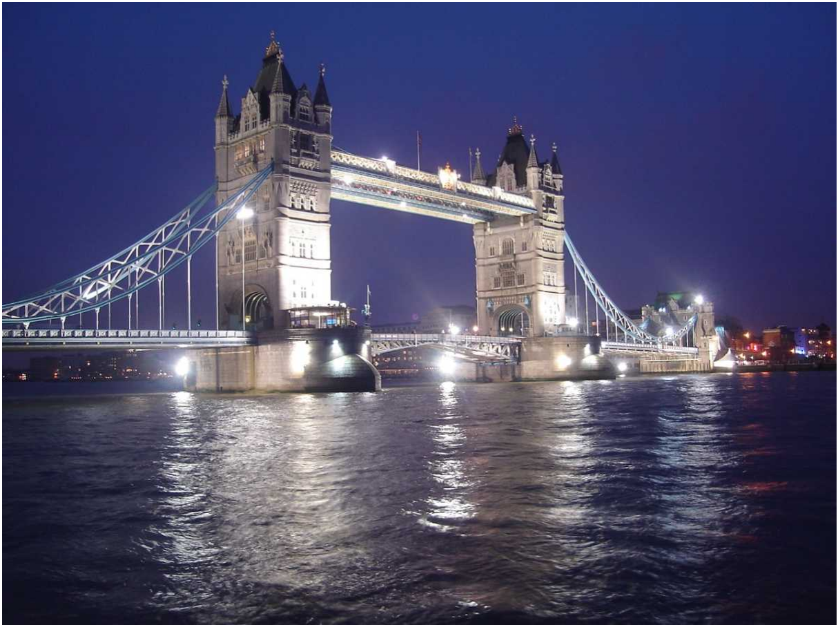
Figura 2.7 – Vista noturna da Ponte da Torre de Londres (Inglaterra), executada entre 1886 e 1894, com clara influência da arquitetura gótica. Segundo JONES e WOODWARD (2000, p. 291), “como a maioria das tradições britânicas, é uma invenção Vitoriana”: uma arquitetura para representar a imponência do imperialismo inglês.
