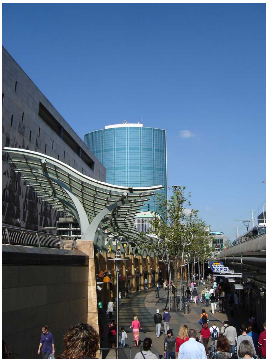
Figura 5.32 – Região central de Roterdã, na Holanda: o centro antigo e a zona portuária foram varridos durante a II Guerra Mundial.
