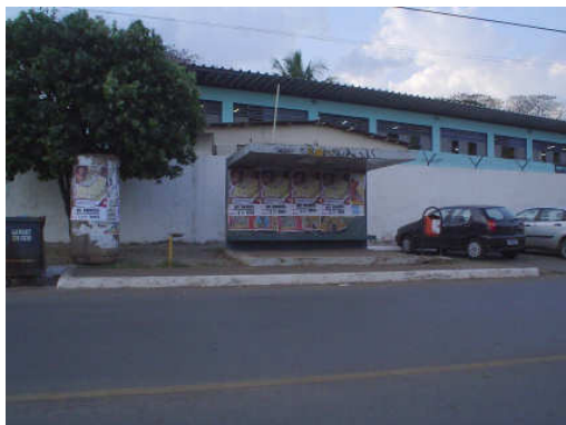
Figura 52 – Abrigo em concreto.
