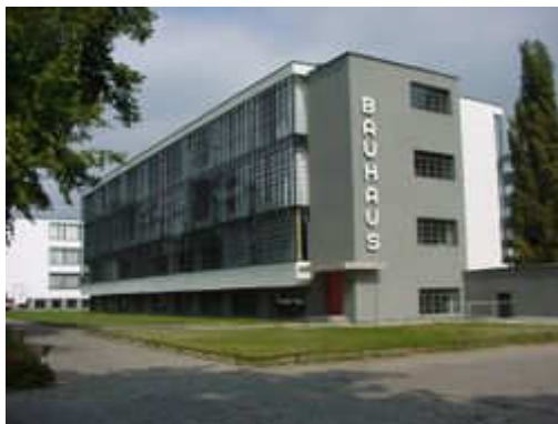
Figura 16 - Sede da Bauhaus em Dessau, Alemanha.
