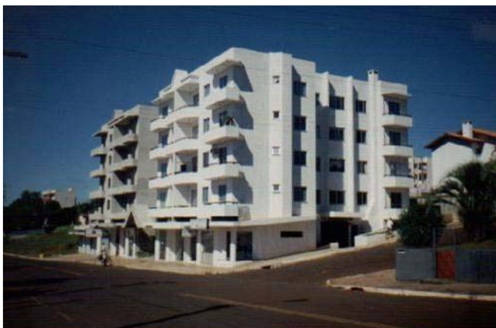
Figura 1.6 – Edifício Altos Montes
