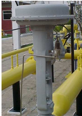
Figura 5.1.1: Pressure Control Valve (PCV) Fonte: Sivini (2006)
