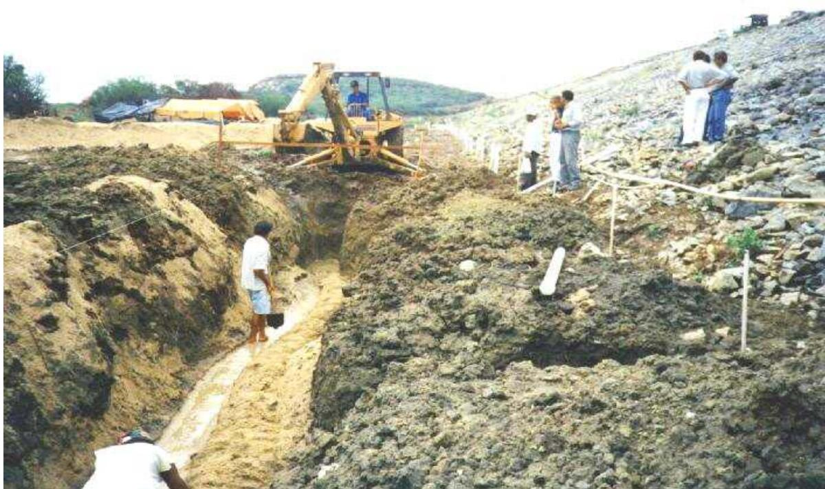
Figura 2.10 –Execução da trincheira drenante para coleta das águas dos poços (CHESF, 1997).
