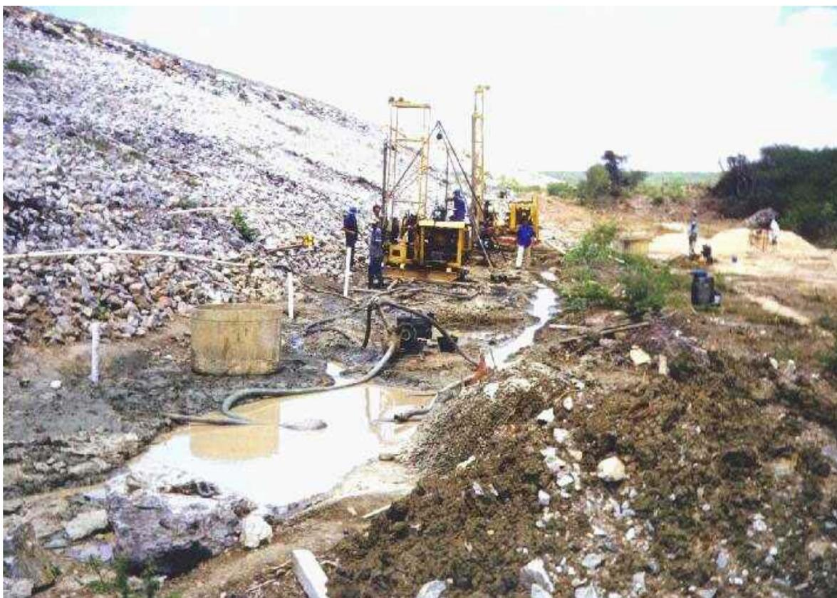
Figura 2.9 –Execução dos poços de alívio à jusante do dique (CHESF, 1997).
