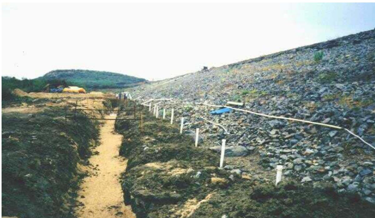
Figura 2.11 – Sistema de poços de alívio e trincheira de drenagem concluídos à jusante do dique (CHESF, 1997).
