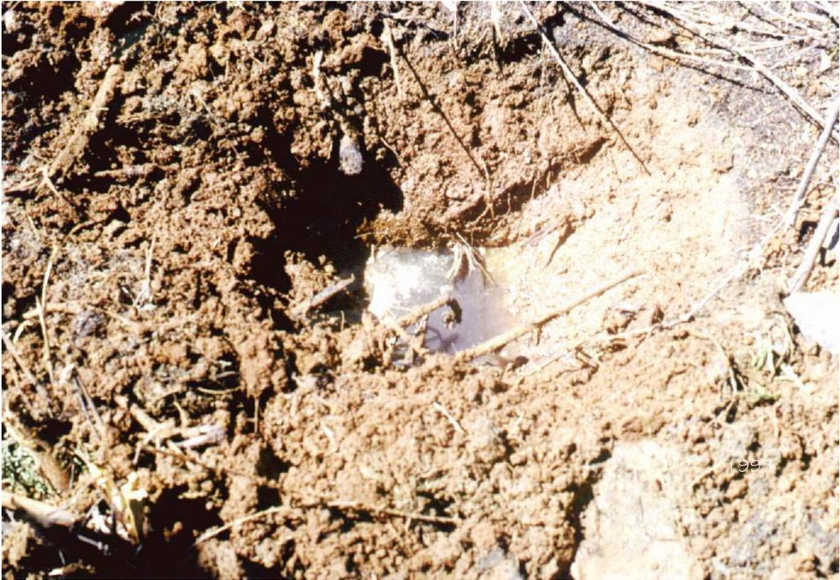
Figura 2.8 – Pontos de surgência à jusante, próximo ao pé do talude do dique A (CHESF, 1997).
