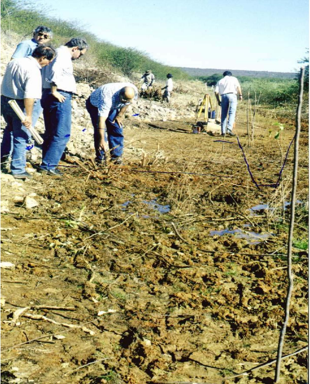
Figura 2.5 – Saturação do terreno e surgência de água à jusante do dique (CHESF, 1997).
