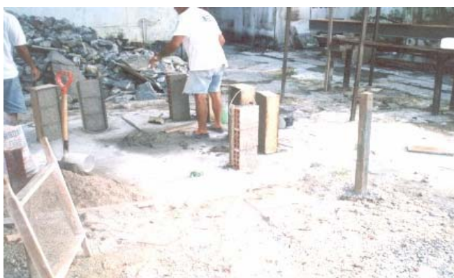
Figura 3.17 – Canteiro da fabricação dos prismas
