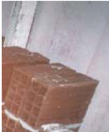
Figura 3.1 – Bloco cerâmico de 8 furos
