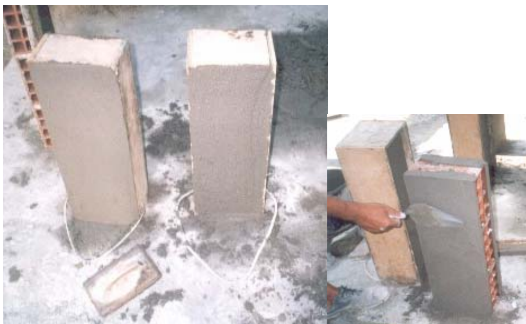
Figura 3.15 – Fôrmas (gabarito) de Madeira
