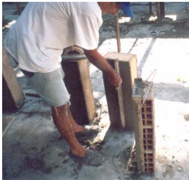
Figura 3.16 – Sarrafeamento do revestimento
