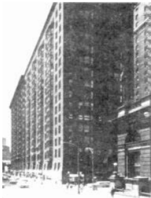
Figura 2.14 (c) – Edifício Monadnock – EUA
