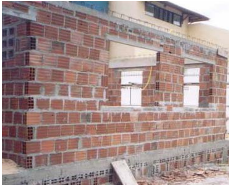
Figura 2.13 (b) – Alvenaria de vedação com função estrutural
