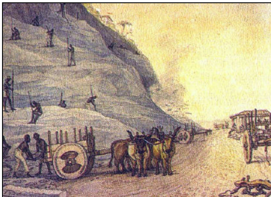
FIGURA 5 - Detalhe de uma ilustração de Debret, de 1826, intitulada pedreira, representando técnicas de extração nos arredores do Rio de Janeiro.
