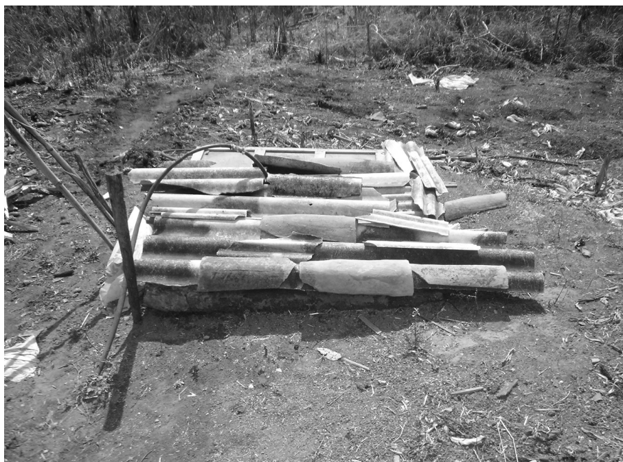
FIGURA 8: Vista de outra cisterna tampada inadequadamente e sem proteção contra enxurrada.
