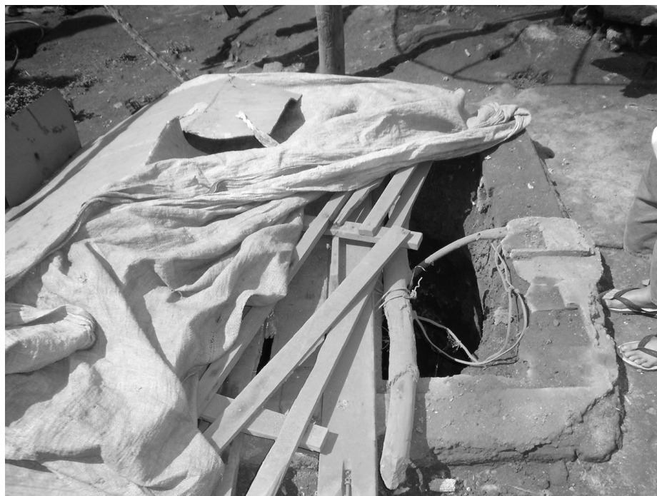
FIGURA 7: Cisterna tampada inadequadamente.
