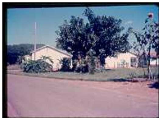
Vista parcial do lado da Escola
