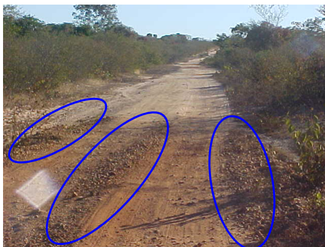
FIGURA 2.33: ESTRADA COM BAIXO NÍVEL DE SEVERIDADE (PERDA DE AGREGADOS)
