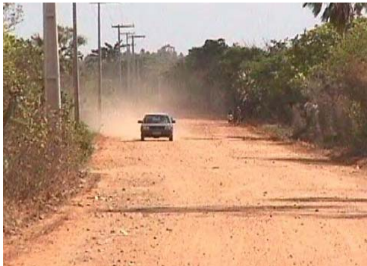
FIGURA 2.21: EXEMPLO DE EXCESSO DE POEIRA – BAIXO NÍVEL DE SEVERIDADE (CORREIA, 2003)
