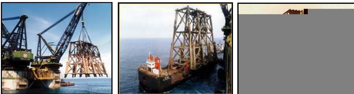
Ilustração 22 – Remoção e Transporte das Jaquetas
