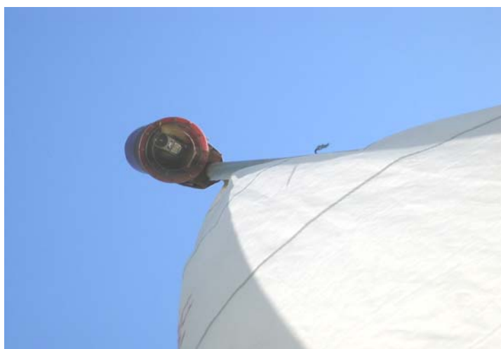
FIGURA 27: Câmera posicionada no mastro.
