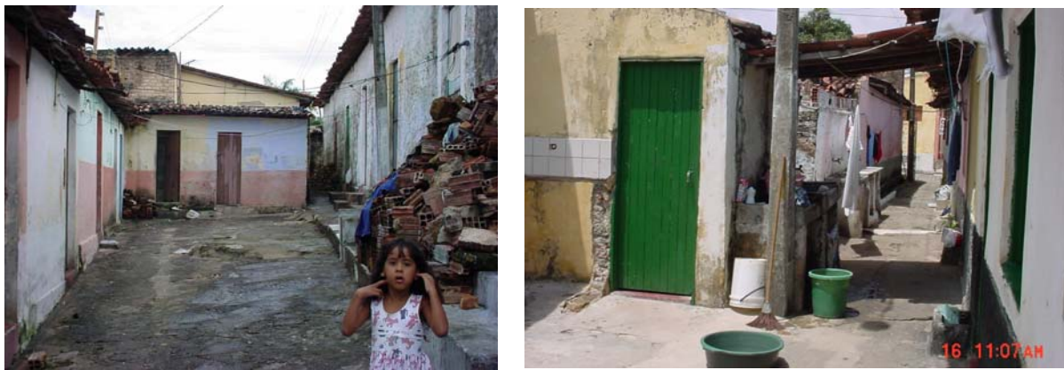
Fotografias 10 e 11 – Vilas precárias, com banheiros coletivos em Nova Descoberta
