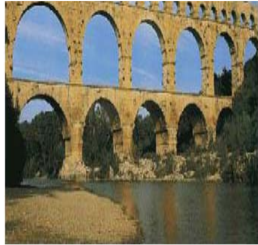
Figura 2.2: Aqueduto de Pont du Gard, França.
