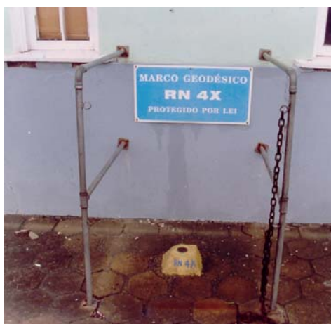
Figura 3.4 – Detalhe da referência de nível fundamental da rede de nivelamento do Brasil.
