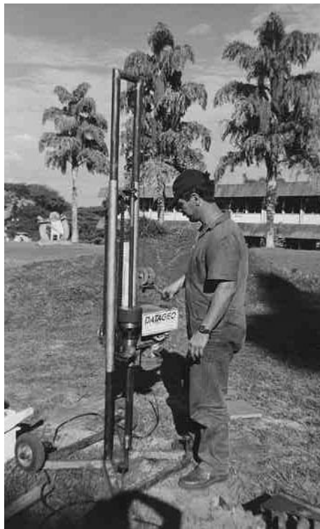
Figura 3.10 - Execução do DPL1
