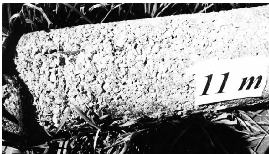
Figura 5.46 - Detalhe do trecho final da estaca A1(O)
