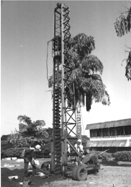
Figura 4.1 - Vista geral da perfuratriz
