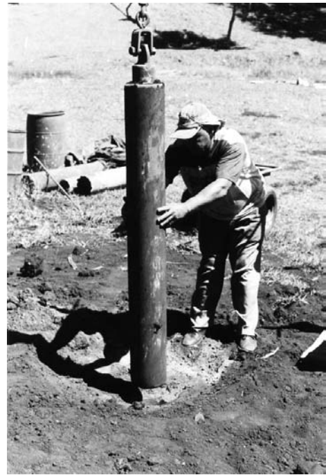
Figura 4.30 - Detalhe do soquete de Strauss
