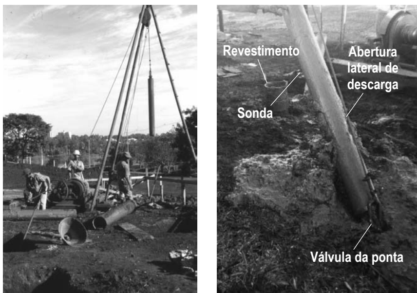
Figura 2.24 - Estacas Strauss – Vista geral e detalhe
