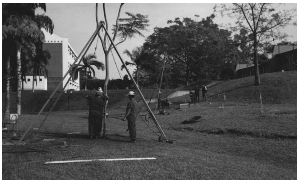
Figura 3.3 - Execução dos furos SP3 (frente) e SP9 (fundo)
