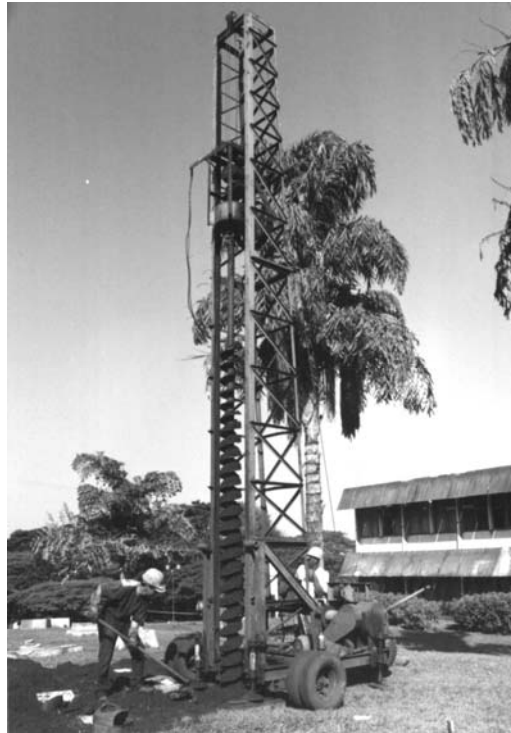
Figura 2.26 - Estacas escavadas com trado mecânico
