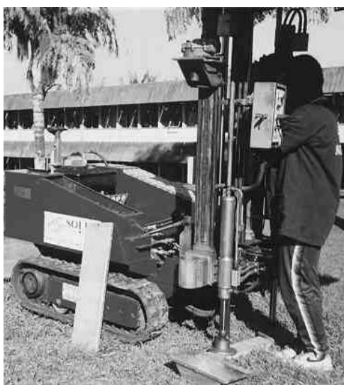
Figura 3.12 - Execução do DPSH9
