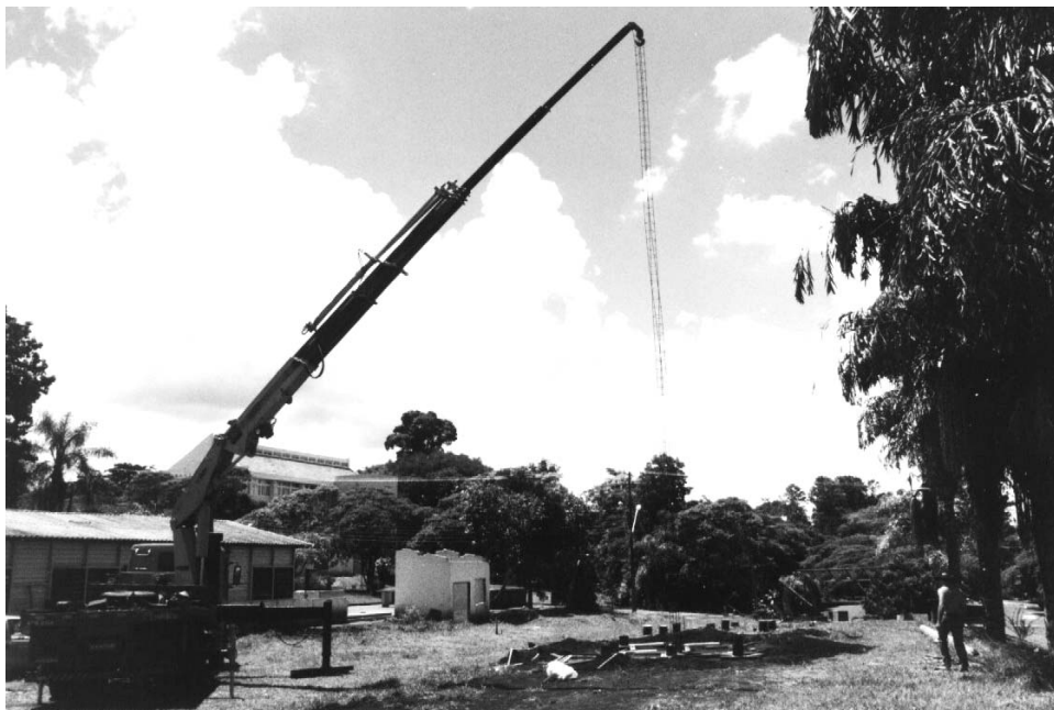
Figura 4.6 - Armadura sendo posicionada
