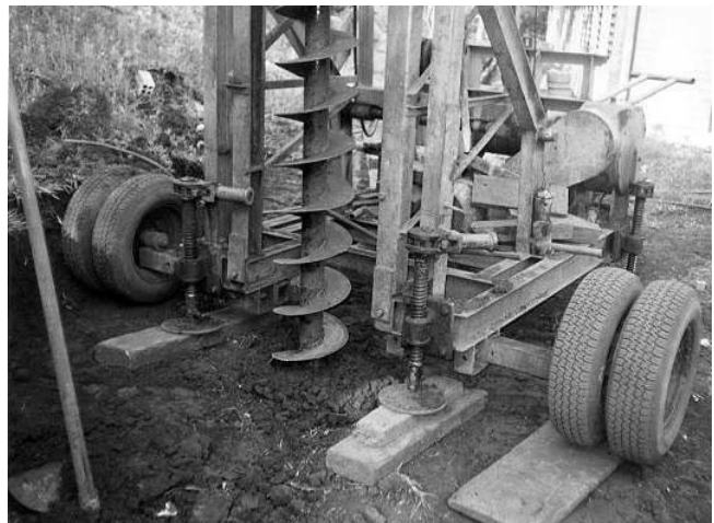
Figura 4.2 - Detalhe da perfuratriz e do trado
