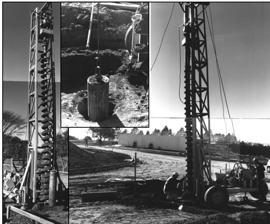
Figura 2.41 - Execução de apiloamento da ponta
