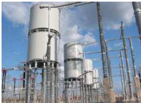
Figura 2.1: Reator limitador de corrente da subestação de Tucuruí 500 kV.
