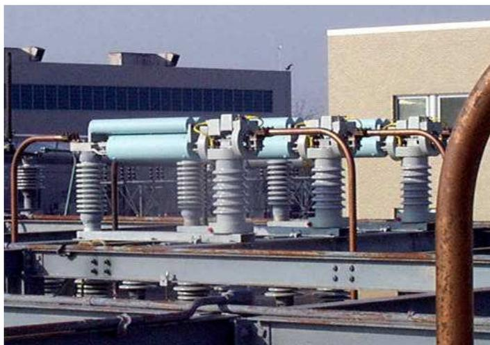
Figura 2.2: Limitador de Corrente de Falta Pirotécnico da G&W Eletric de 38KV e 2500A.
