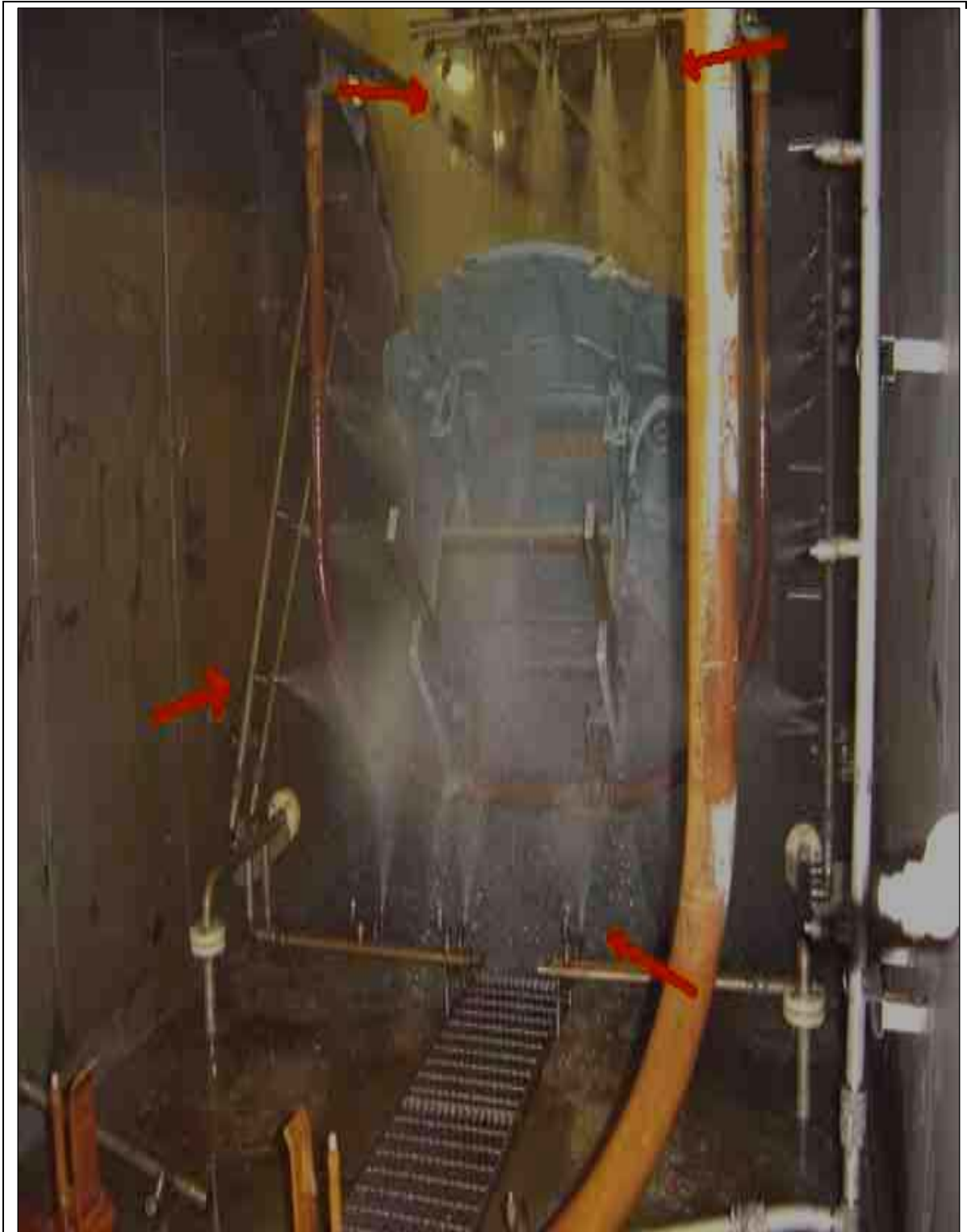
Figura 10 – Lavagem da carroceria com sistema de spray com água deionizada
