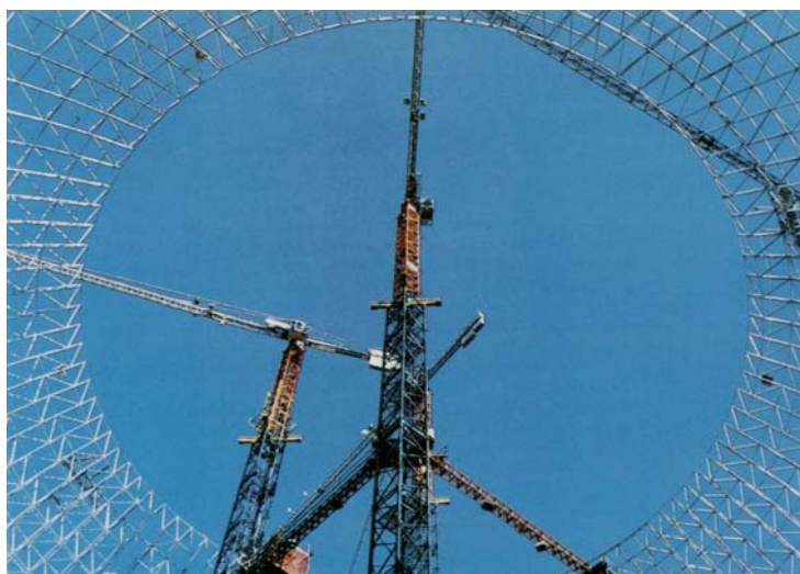
Figura 2.2 - Fase final da montagem de um domo em estrutura metálica tubular (MEYER, 2001)
