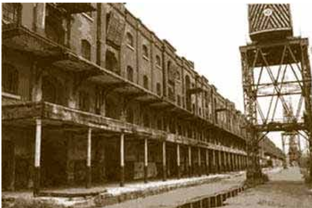
Figura 39 - PUERTO MADERO DETERIORADO
