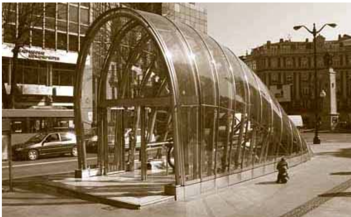
Figura 37 - ESTAÇÃO DE METRÔ, DE SIR NORMAN FOSTER
