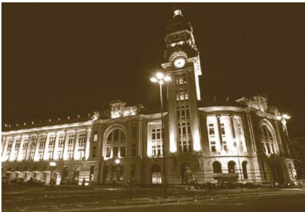
Figura 45 - ESTAÇÃO JÚLIO PRESTES, ATUALMENTE
