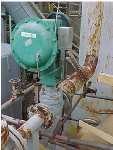
**Válvula de controle com vazamento de AGC contaminando sistema de recuperação de condensado na planta de uréia**
