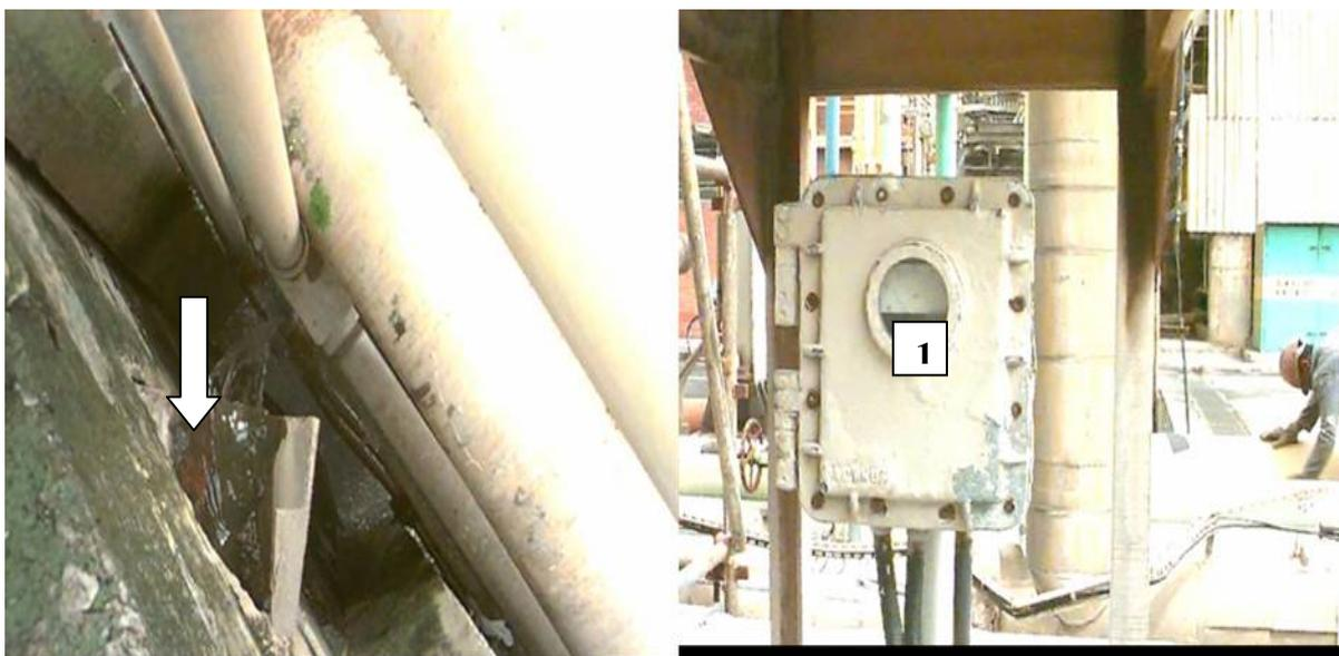
**Foto 7** - Aparelho (1) de medir condutividade em água desmineralizada ou condensado de processo da uréia e calha de descarte ao S.N.
