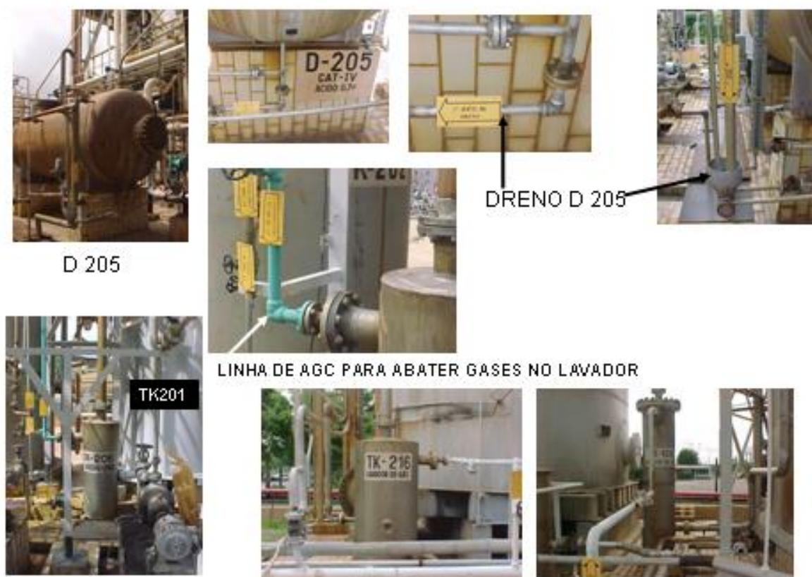
TK201 de Ácido concentrado e TK206, TK 216 e TK 106 lavadores de gases dos tanques
