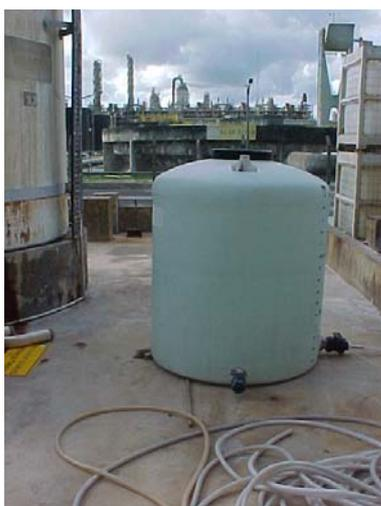
**Foto 4** – Vaso para solução ácida da planta de ácido nítrico da figura 29
