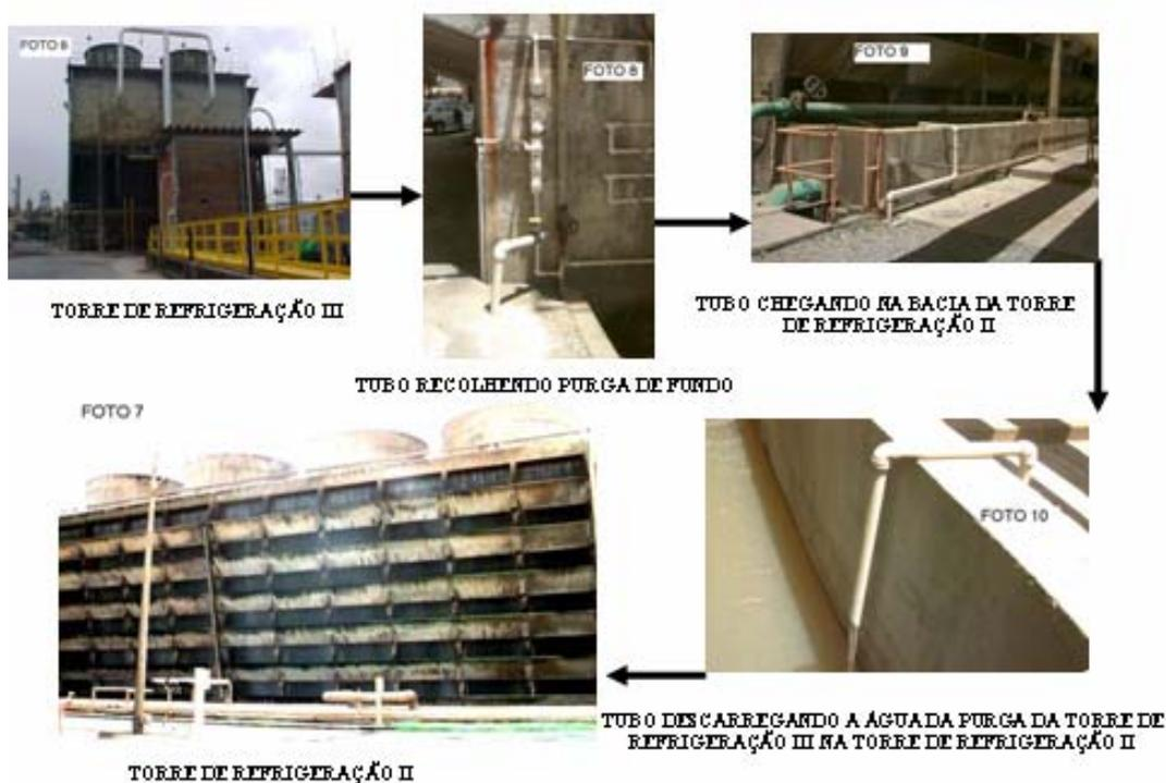
**Foto 8** – Purga da torre III, em reciclo, vertendo água na bacia da torre II
