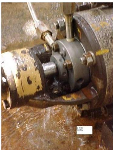
**Foto 16** – Bomba com vazamento de água na gaxeta
