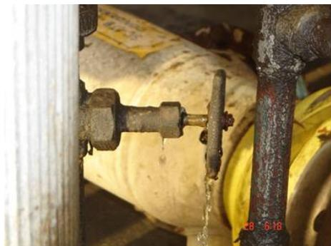
**Foto 15** – Válvula com vazamento de água
