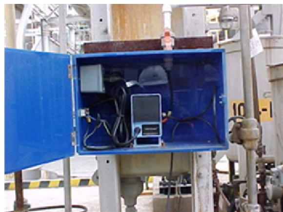
**Bomba dosadora de solução concentrada para o tanque de diluição**
