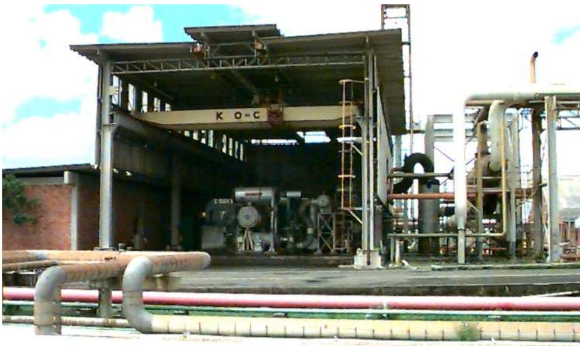
**Foto 23** - Estação de compressão de CO<sub>2</sub> para injeção em poços de petróleo (1995).
