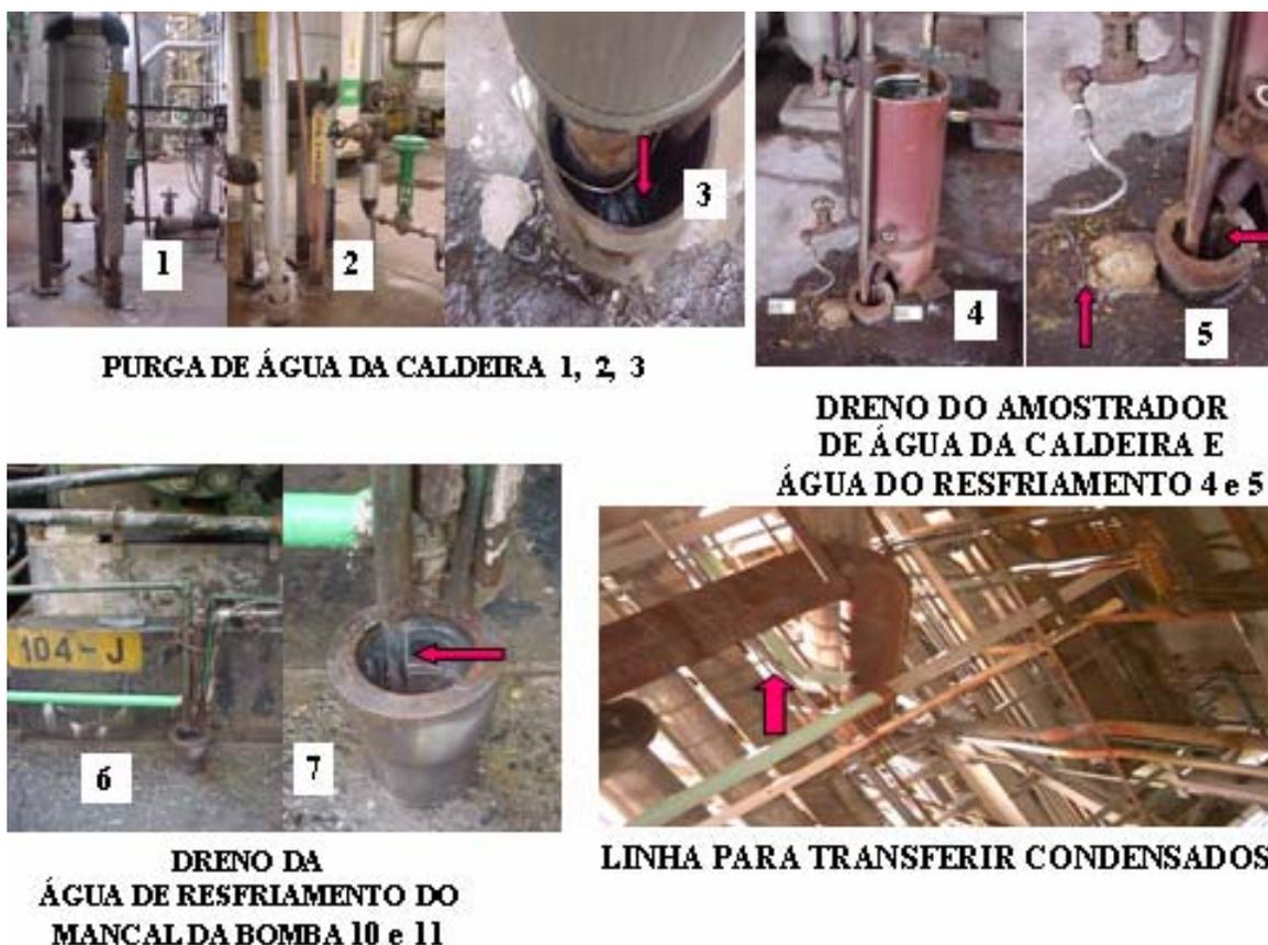
**Foto 19** – Diversos pontos de descarte de águas que podem ser recicladas à torre II
