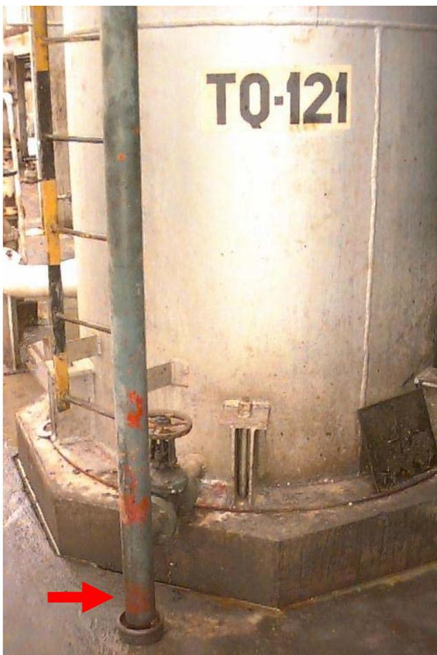
**Foto 22** – Perda de água desmineralizada pelo dreno do tanque
