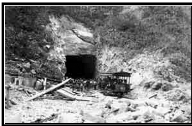
Figura 2: Obras de construção do Túnel Velho - 1890 Imagem: copacabanaonline.com.br/historia
