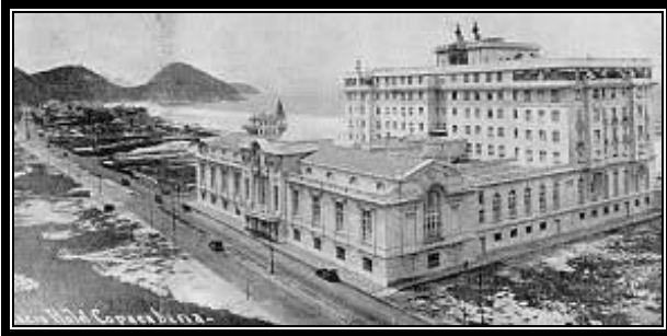
Figura 4 : Copacabana Palace Hotel - 1923 Imagem: Arquivo Geral da Cidade do Rio de Janeiro
