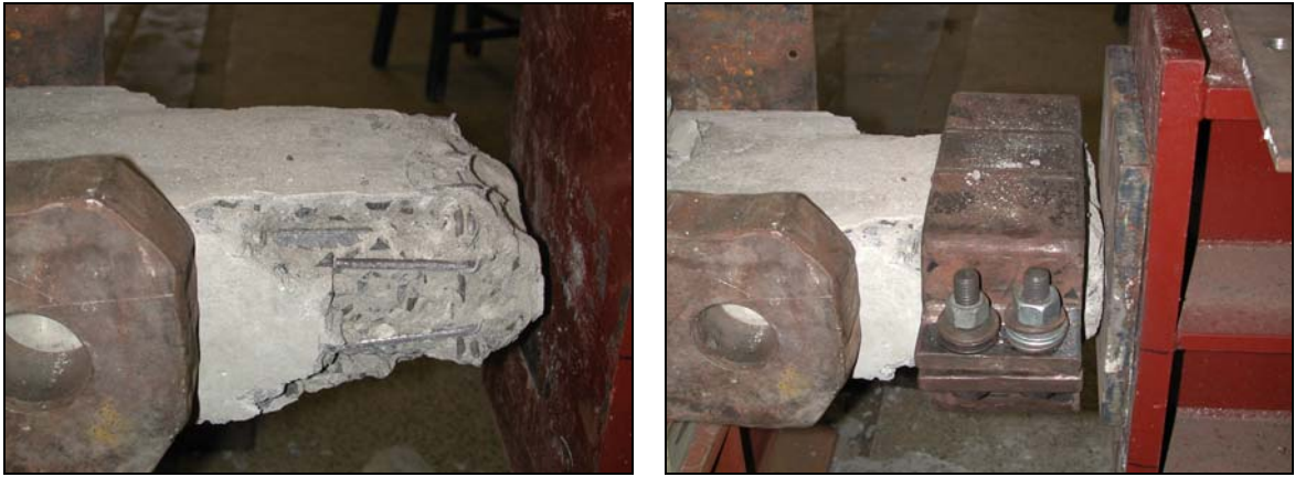
Figura 5.2 – Correção da superfície da extremidade do pilar e reforço com camisa metálica.
