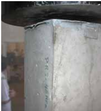
Figura 6.34 – Regularização da superfície com massa plástica.
