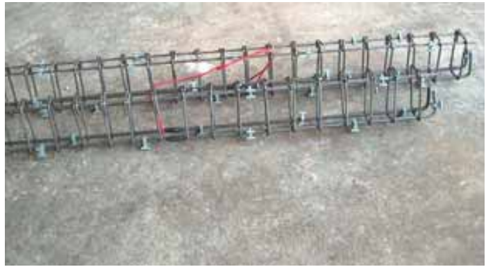
Figura 6.42 – Armadura das vigas.
