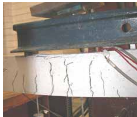
Figura 6.58 – Detalhe da fissuração da viga.
