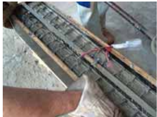
Figura 6.44 – Concretagem das vigas: adensamento.
