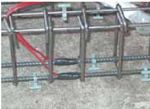
Figura 6.43 – Detalhe dos extensômetros colados no aço – barras inferiores.
