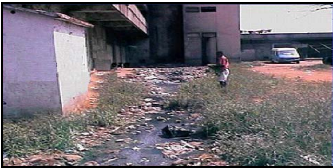
FIGURA 7: Galpão onde se encontra instalada máquina para limpeza de grãos (café, arroz, milho, etc.) liberando água residuária contendo esgoto, graxas e óleos.
