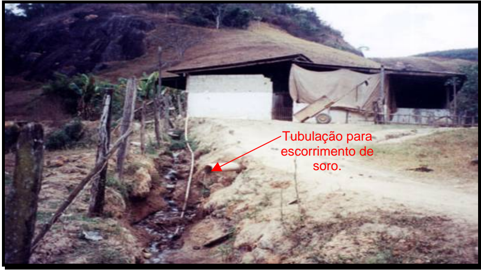
FIGURA 15: Aspecto do saneamento de uma residência localizada na bacia hidrográfica do ribeirão São Nicolau Grande.
