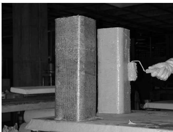
Figura 5.9 – Encamisamento com fibras de carbono
