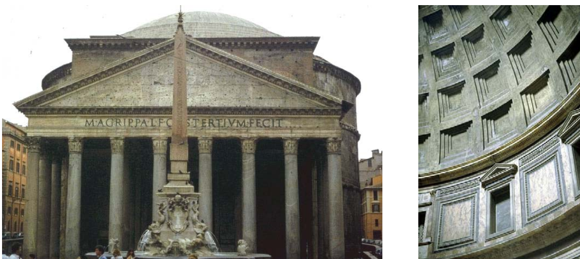
Figura 2.3. Detalhes da abóbada em concreto do Panteão. Fonte: http://harpy.uccs.edu/roman/
