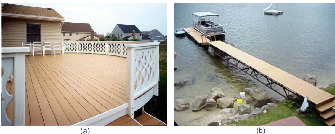
Figura 2.12. Construção de píeres ou deques com elementos de plástico reciclado da empresa Plastic Lumber Yard (EUA)
