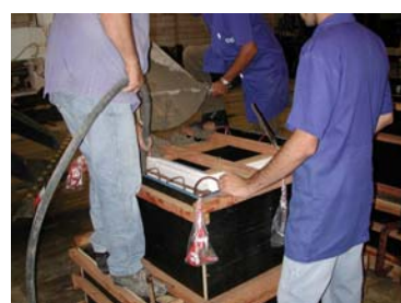
3º) Concretagem do colarinho
