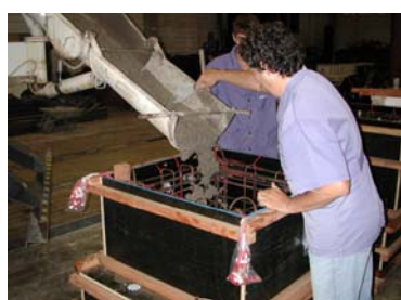
1º) Concretagem da base da fundação
