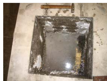
3º) Poliestireno expandido impregnado na região interna do cálice
