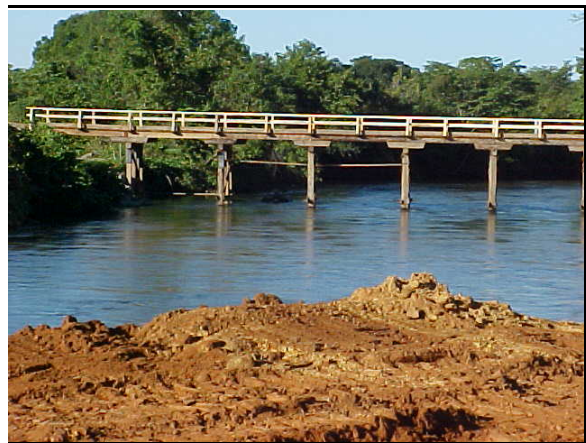
Figura 7. Ponte de madeira sobre o Rio Manuel Alves
