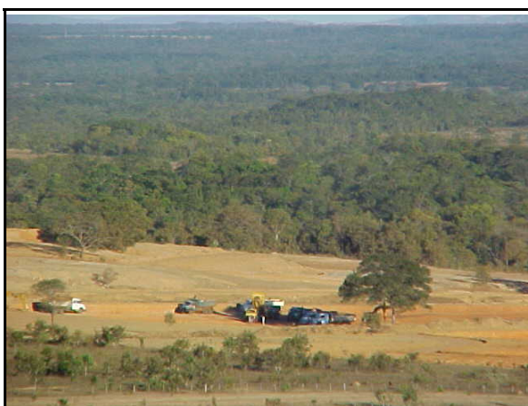
Figura 32. Implantação do canteiro de obras
