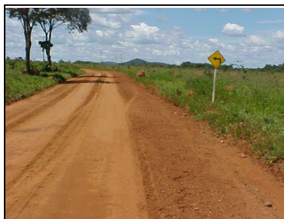
Figura 33. Abertura de vias de acesso
