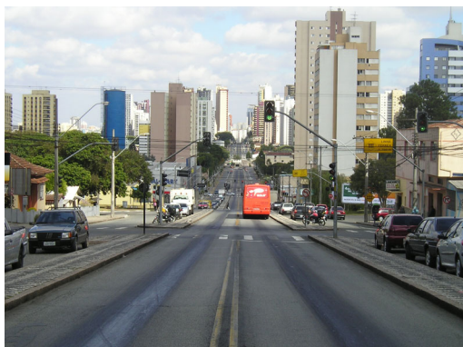
Setor estrutural norte. (Foto da autora)
