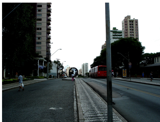
Setor estrutural norte. (Foto da autora)
