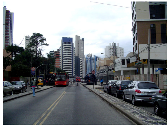
Setor estrutural sul. (Foto da autora)
