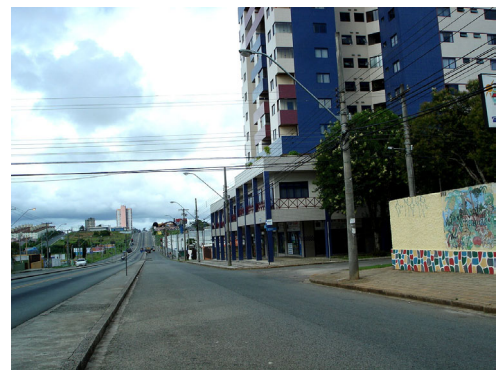
Setor estrutural norte. (Foto da autora)
