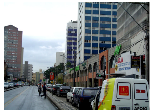
Setor estrutural sul. (Foto da autora)
