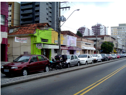
Setor estrutural sul. (Foto da autora)
