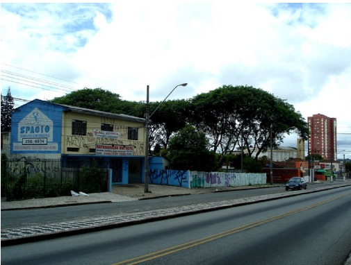
Setor estrutural norte. (Foto da autora)
