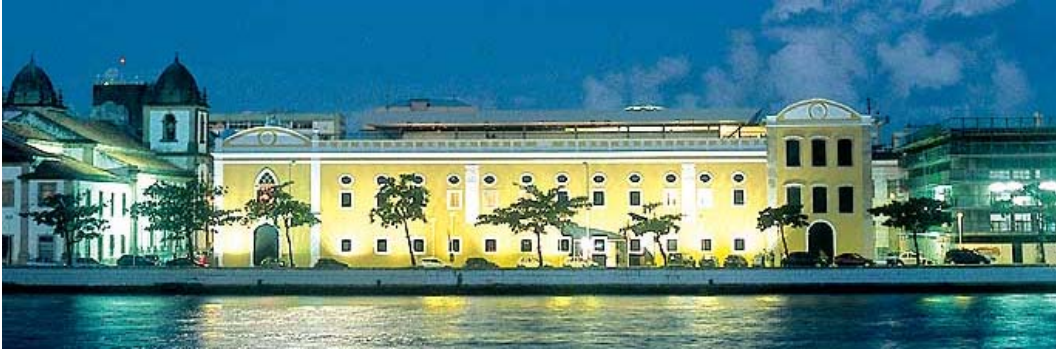
Figura 1.4 - Paço Alfândega (Fachada)
