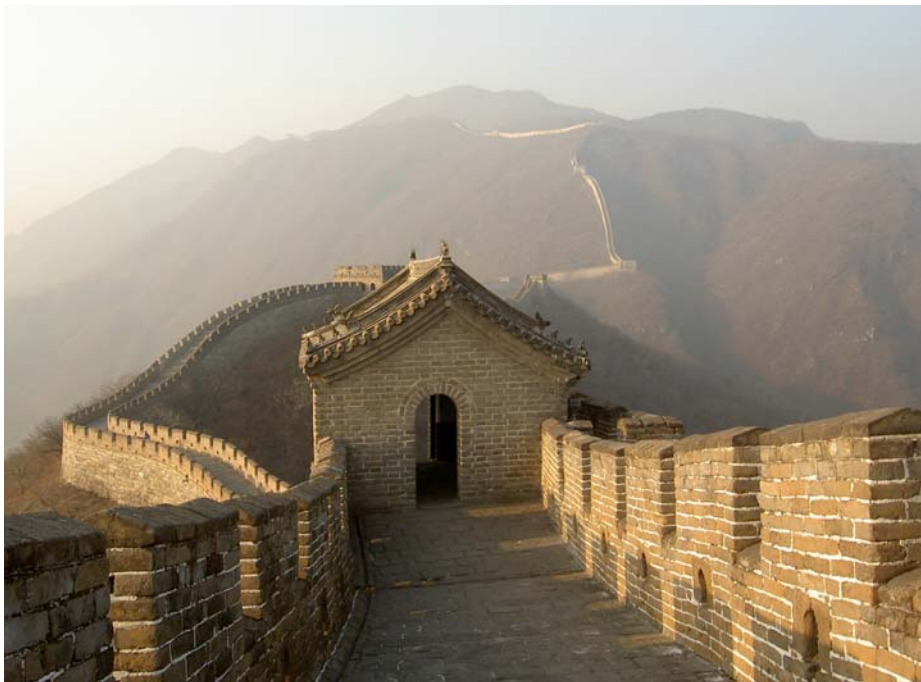
Figura 1.3 - Muralha da China
