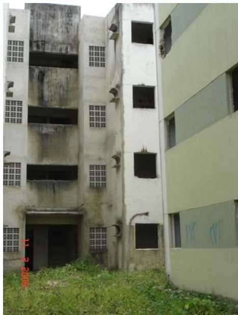
Figura 5.2 – Bloco A girado para esquerda – Bloco C ao fundo
