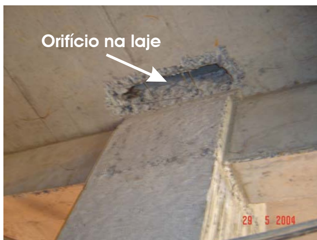
Figura 2.13 - Orifício realizado na laje para passagem do concreto
