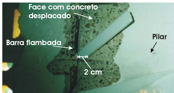
Figura 2.21 - Vista frontal do pilar, área interna do prédio (ROCHA et al., 2002)
