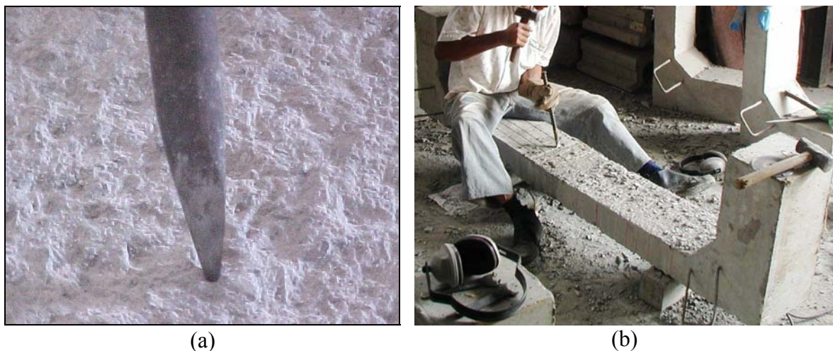
Figura 3.20 – Fotografias da escarificação dos pilares
