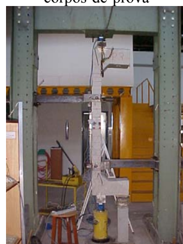
(i) pilar posicionado na estrutura de reação
