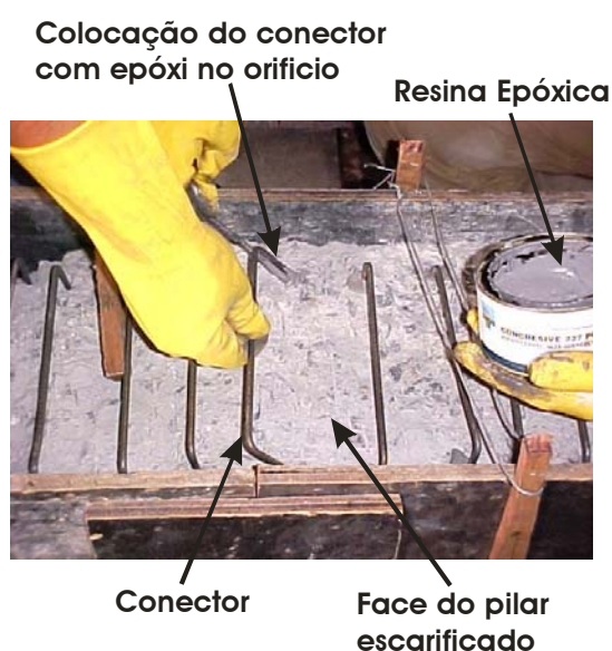
Figura 3.21 – Fotografia da colagem dos conectores ao pilar e forma preparada para receber o novo material
