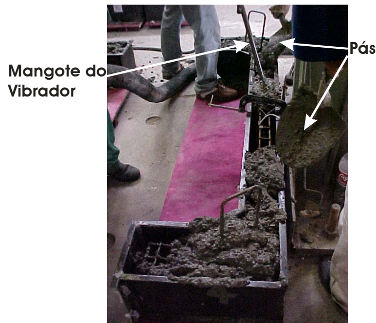
Figura 3.9 – Concretagem e adensamento
