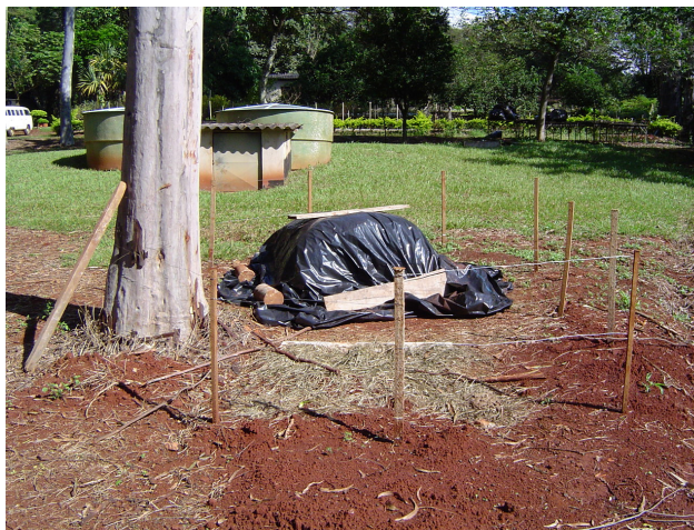
Figura 5. Área dos sistemas de compostagem completamente cercada para proteção.
