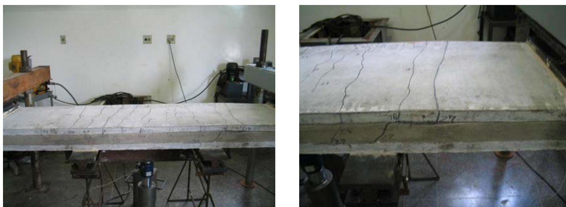
Figura 5.9 – Configuração das fissuras no painel P-SL-100.
