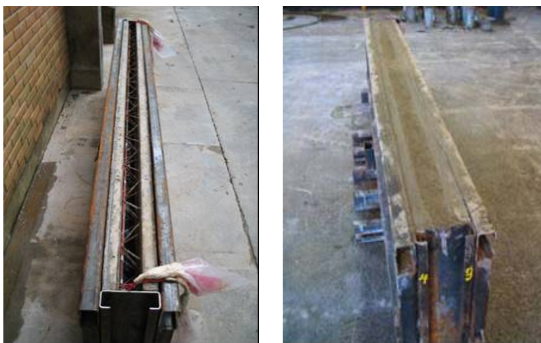
Figura 4.9 – Segunda etapa para concretagem para painel com ancoragem de placa a núcleo.
