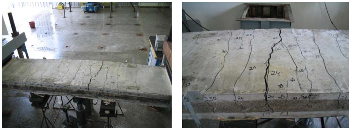
Figura 5.7 – Configuração das fissuras no painel P-2L-PN-100.
