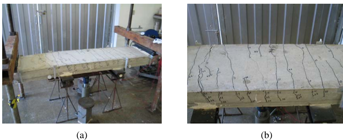
Figura 5.4 – Configuração das fissuras no painel P-2L-CPN-45.
