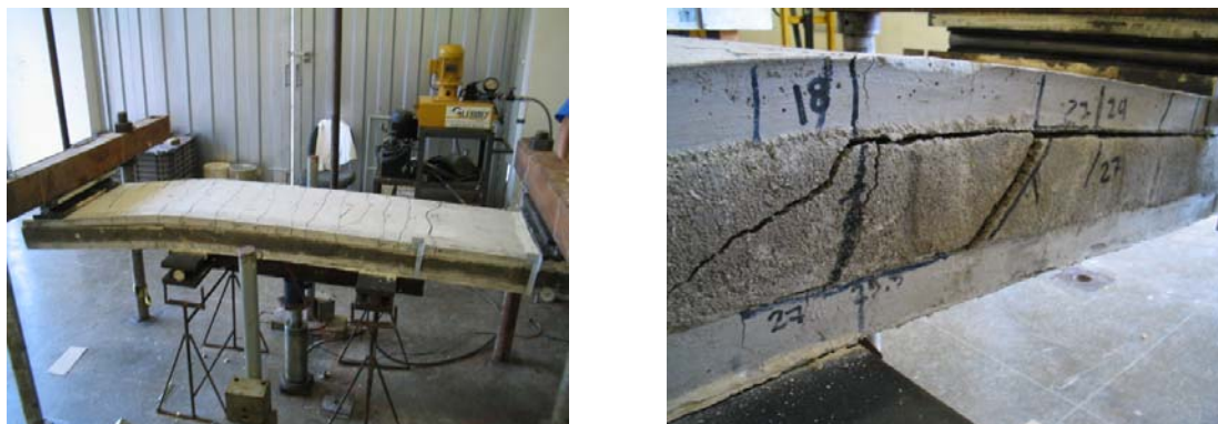
Figura 5.8 – Configuração das fissuras no painel P-1L-PN-100.
