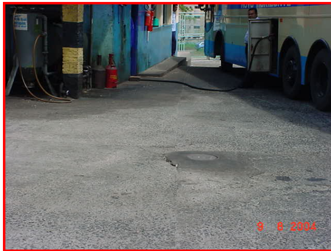
Figura 38: Abastecimento sem canaleta periférica e sem o separador de água e óleo
