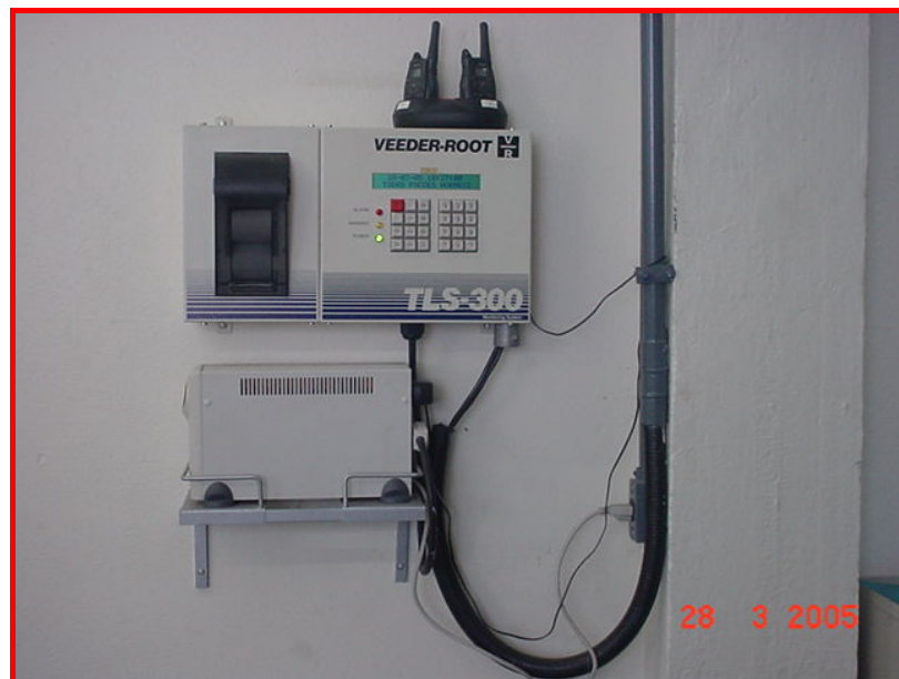
Figura 45: Sistema de monitoramento que controla volume de combustível no tanque e vazamento
