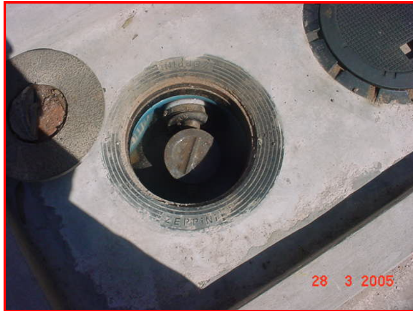
Figura 44: Bocal de descarga do combustível por gravidade e sistema possuindo sump
