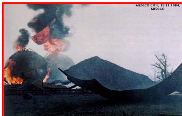
Foto 3 - BLEVE em esferas de GLP. Fonte: Lees (1996), adaptado de Esteves (2004).
