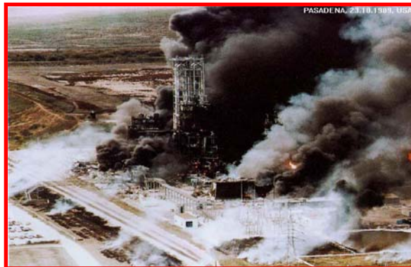
Foto 7 - UVCE em planta de processamento de polietileno. Fonte: Lees (1996), adaptado de Esteves (2004).
