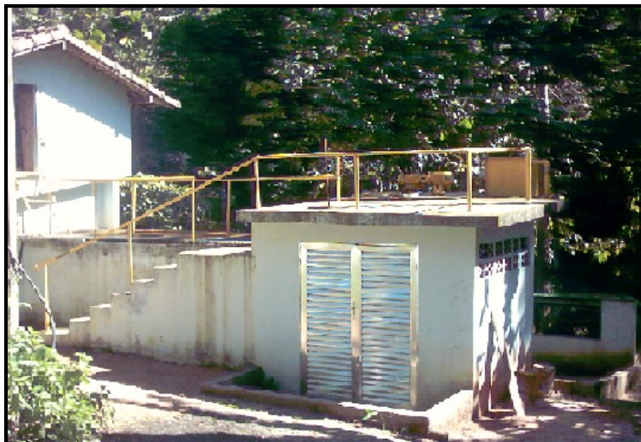
Figura 15 – Vista geral da estação de tratamento de Glicério
