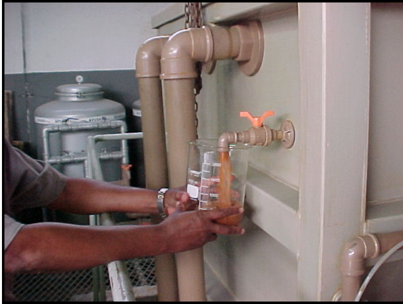
Figura 22 - Retirada de amostra para verificação no nível de coagulação após eletrólise.
