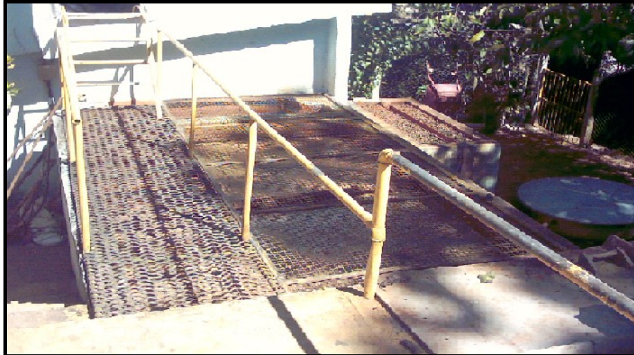
Figura16 – Estação de tratamento eletrolítico – Parte superior do reator
