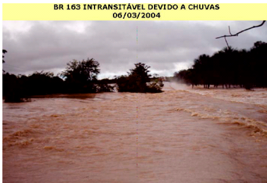
Figura 11. Detalhe das condições da rodovia BR 163. Fonte: ANUT – Associação Nacional dos Usuários do Transporte de Cargas.
