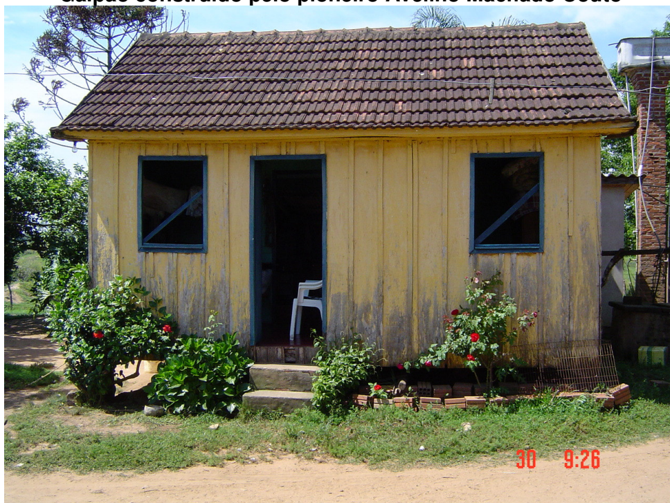
FIGURA 6 Residência remanescente dos lotes 1 a 17, assentamento "UM"
