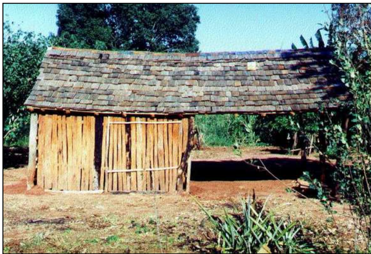
Foto 78. Vista lateral da habitação 2 após a conclusão, onde se vê a cobertura de tábuas de cedro.
