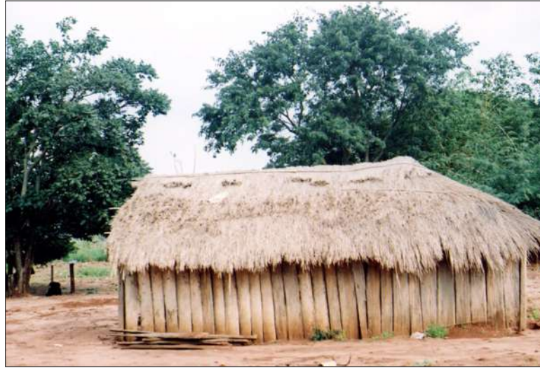
Foto 6. Habitação de três águas, parede de madeira e cobertura de sapé
