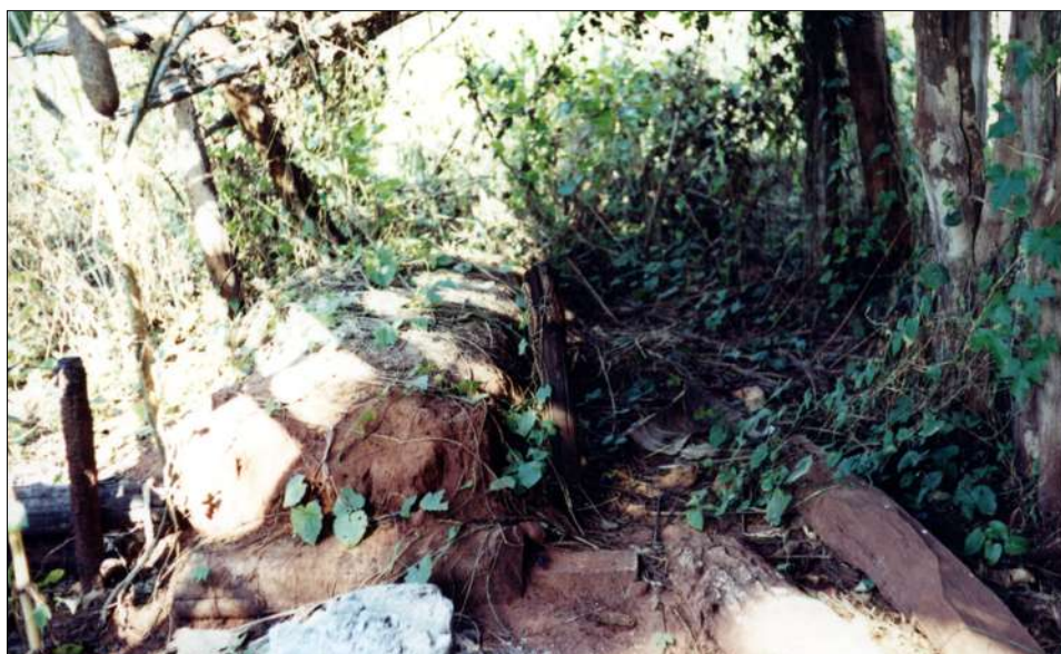
Foto 100. Fogo doméstico no interior da casa em colapso, fev/2003
