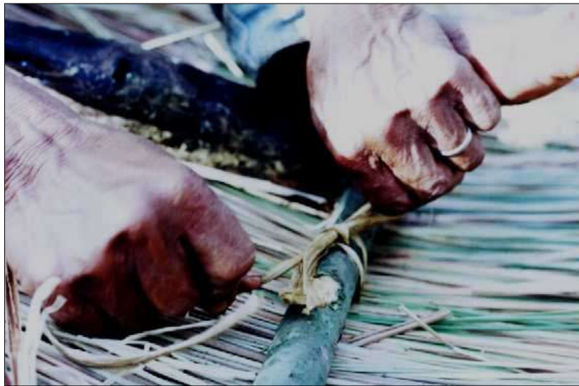
Foto 79. Amarração da cobertura feita com fibra de gua'a pyto
