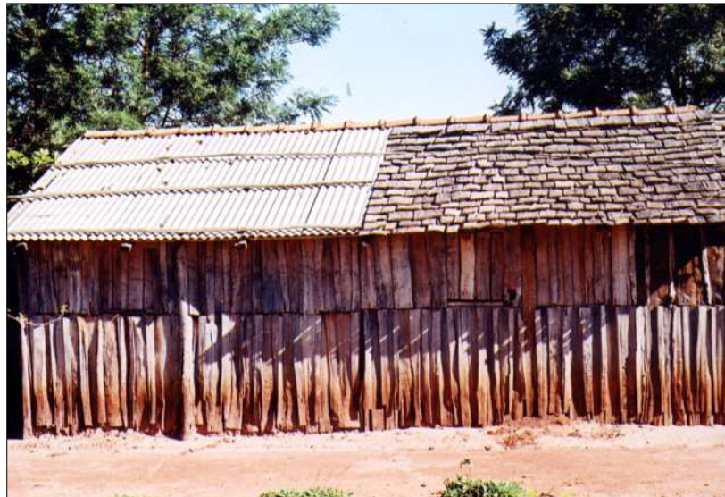
Foto 12. Habitação com dois tipos de cobertura: amianto e tábua
