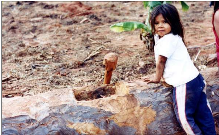
Foto 16. Estrutura para pilar feita em tronco
