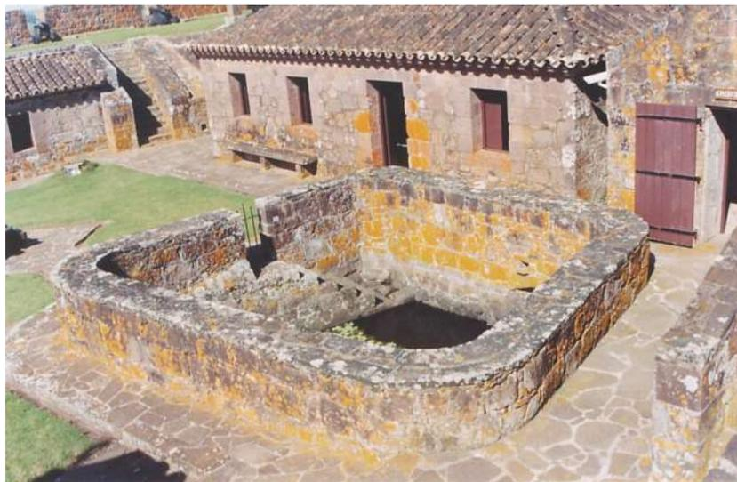
Poço com 4 metros de profundidade, escavado na rocha.
