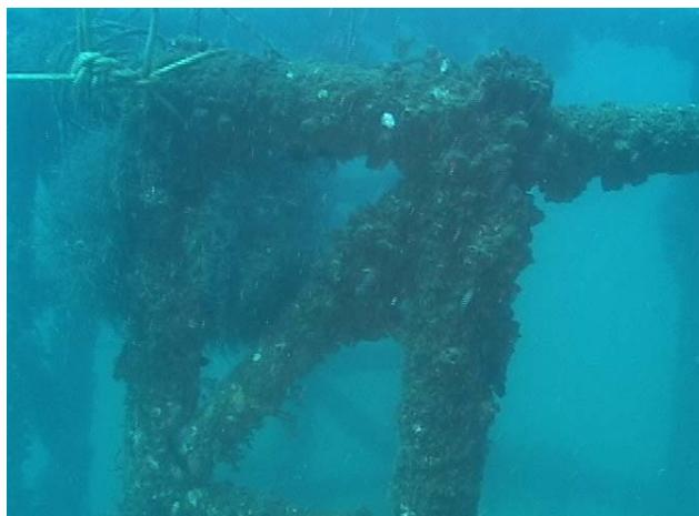
**Figura 86** - Cracas incrustando grande área deste módulo
