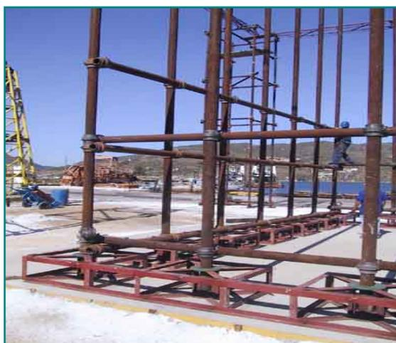
**Figura 57** - Detalhe da colocação dos tubos horizontais
