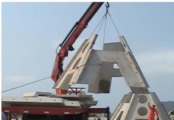
**Figura 70** - Içamento da estrutura de concreto
