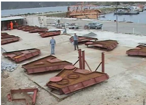
**Figura 66** - Disposição das fôrmas no canteiro de obras
