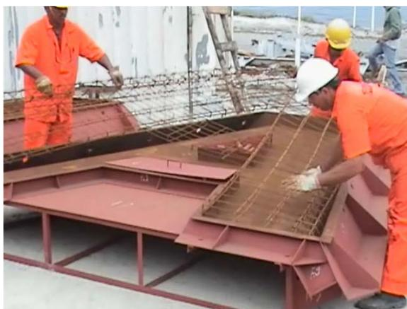
**Figura 68** - Posicionamento das ferragens no interior das fôrmas
