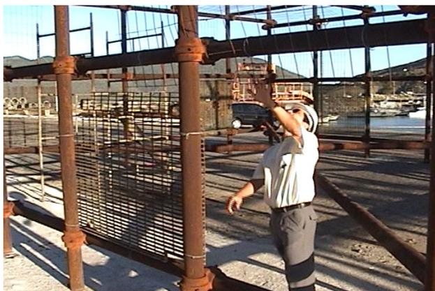
**Figura 62** - Verificação do posicionamento das telas e grades de aço na estrutura
