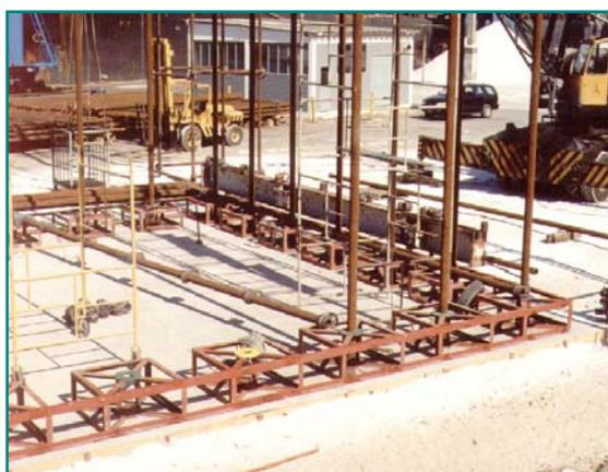
**Figura 56** - Início da montagem do módulo tubular de aço
