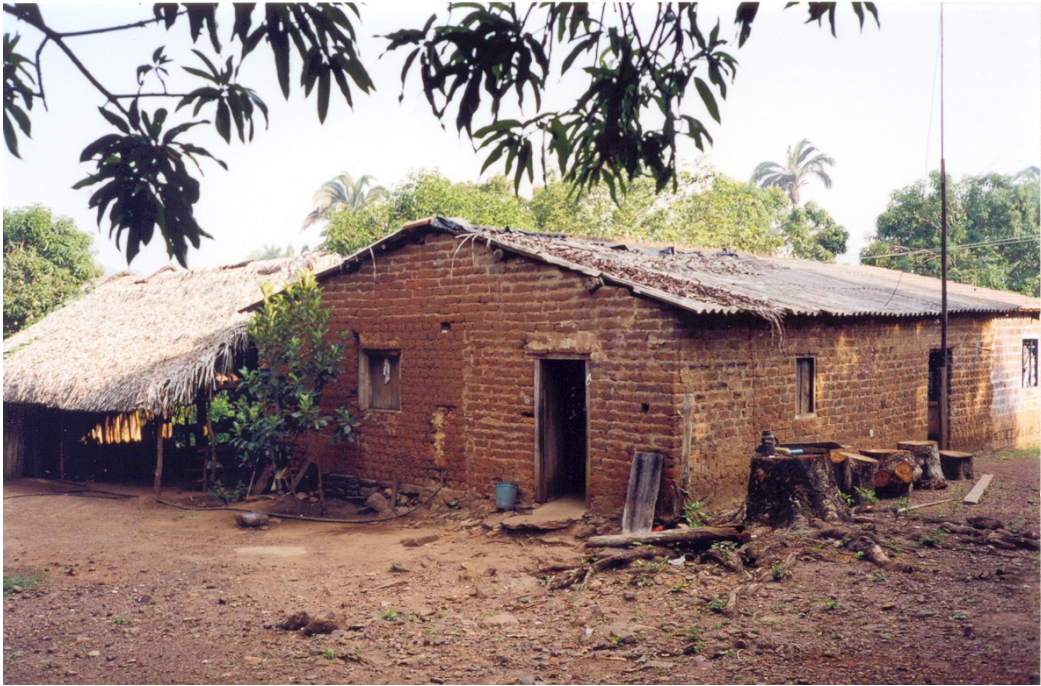
Figura 5.2.6 Casa típica de adobe-área rural de Taquaruçú
