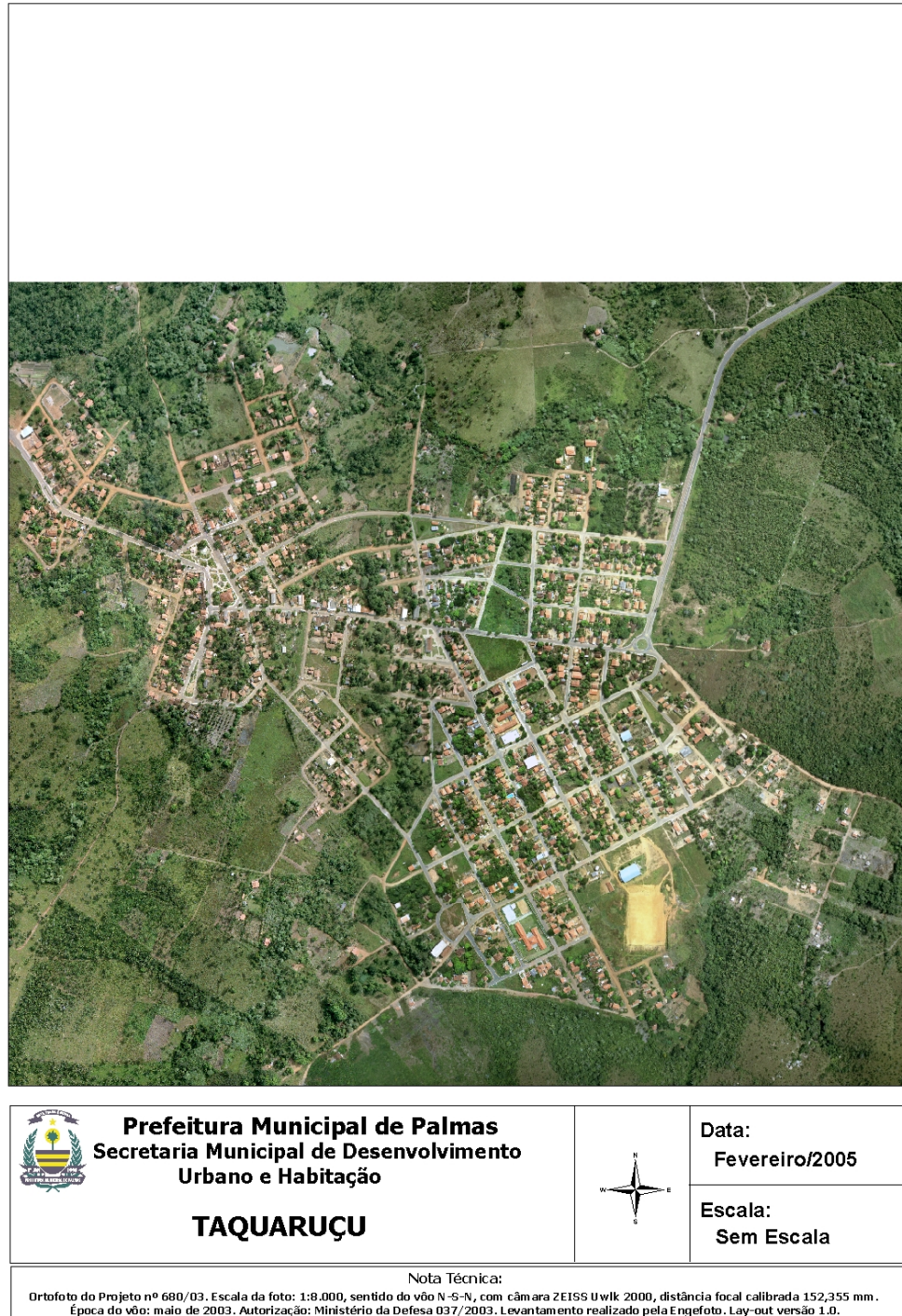
Figura 5.2.8 Vista aérea do Distrito de Taquaruçú
