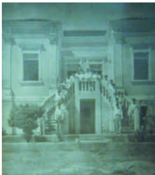
Figura 1 - Residência do Diretor na Fazenda Modelo de Criação de Urutaí/GO, Castelinho construído em 1919.
