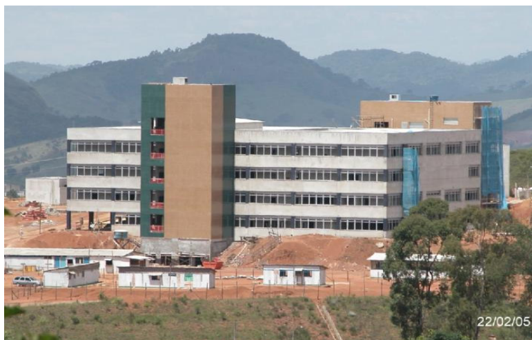
Figura 2.2.1.4 – Centro de Atenção à Saúde (1º módulo) Universidade Federal de Juiz de Fora – UFJF
