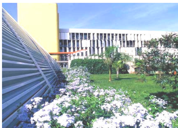
Figura 2.4.1.2 – Hospital Sarah de Belo Horizonte / MG Centro de reabilitação (hospital geral reformado)
