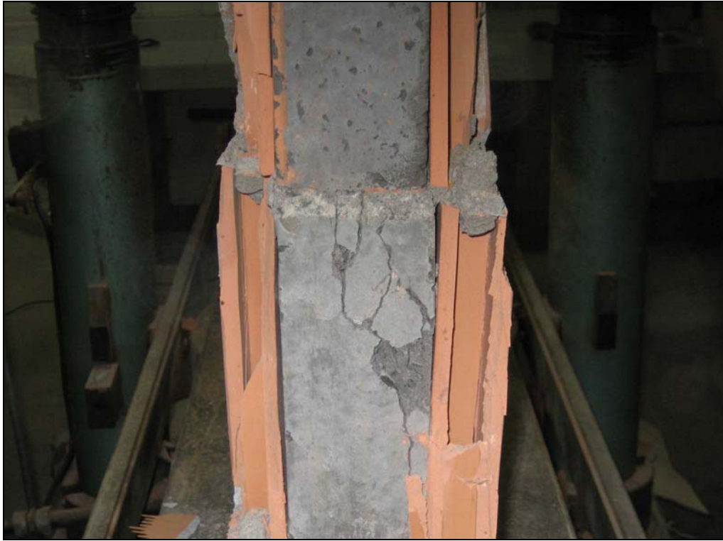
Figura 4.21 – Graute, interface bloco/argamassa.
