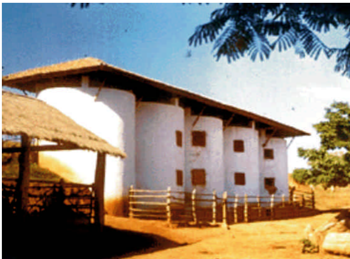
Figura 82. Silos Aéreos, São João Nepomuceno, MG.
